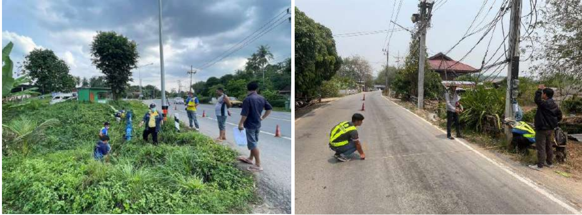
รูปที่ 3-1 การตรวจสอบสาธารณูปโภคและพื้นที่ก่อสร้าง
